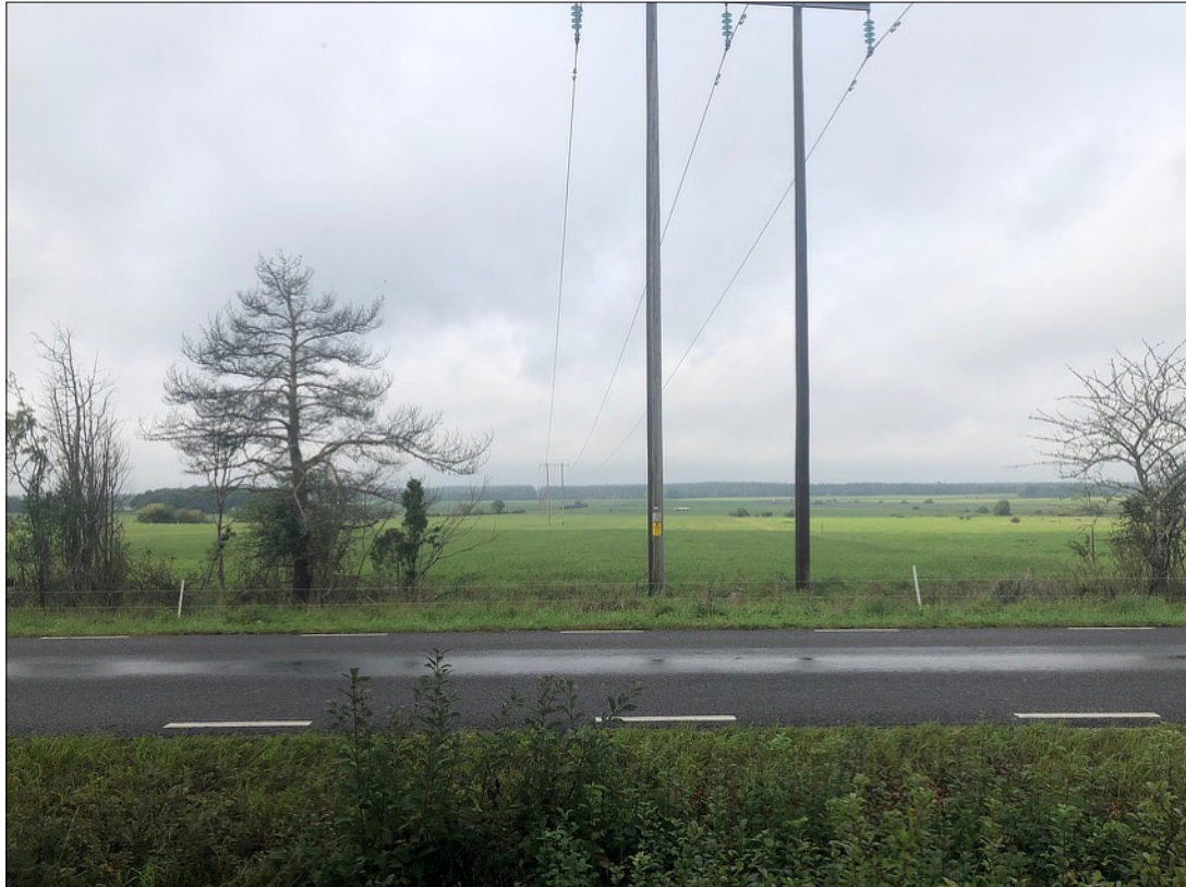
Figur 33. Kraftledningen sedd från öster med utblick över dalgången söder om Hejnum kyrka en regnig dag.
