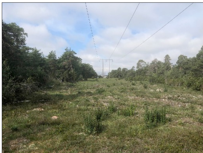
Figur 23. Kraftledningsgatan strax öster om transformatorstationen vid Bäcks.
