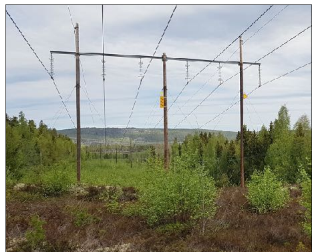
Figur 27. De två typerna av kraftledningsstolpar det handlar om. Till vänster stålstolpe med en höj kring 30 meter och ovan betongstolpar (gråfärgade) med en höjd av 16-19 meter.
