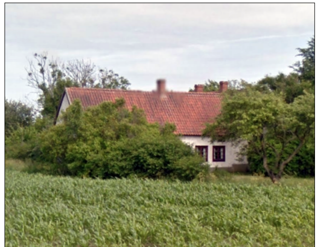
Figur 23. Bjärges norra part i form av en envånings parstuga. Foto: Google Maps.
